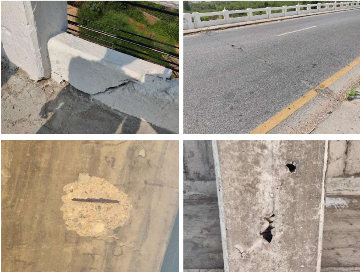
รูปที่ 9-4 ตัวอย่างบางส่วนของภาพความเสียหายของสะพาน
