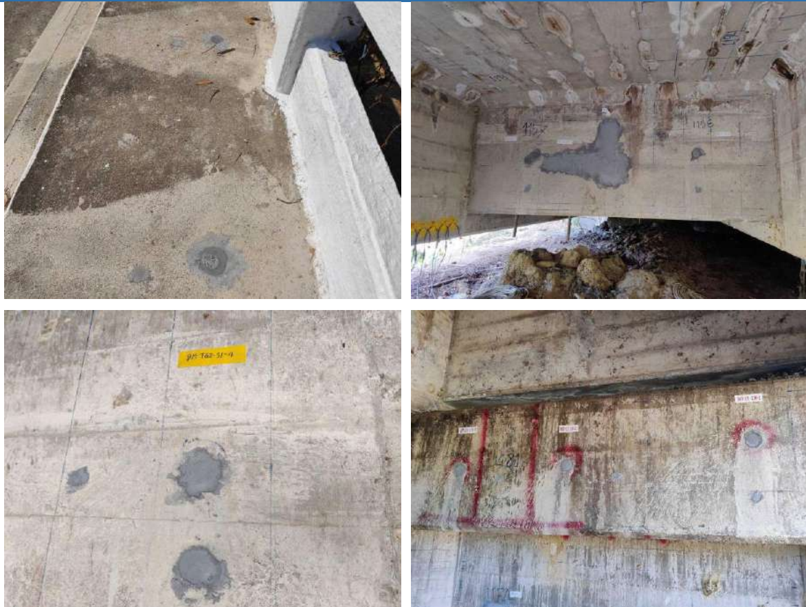
รูปที่ 8-9 รูปการซ่อมคืนสภาพจากการเก็บวัสดุทดสอบกำลังคอนกรีต
