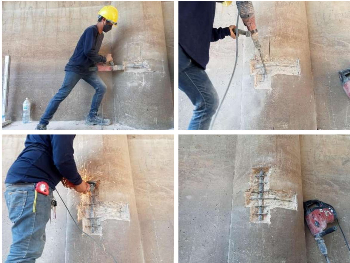
รูปที่ 9-10 รูปการทำงานเก็บวัสดุทดสอบกำลังเหล็กเสริม
