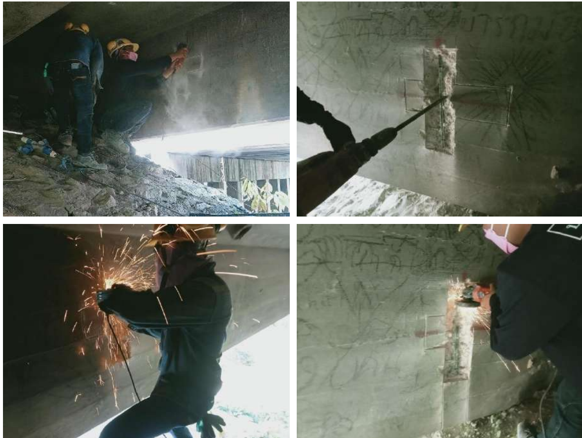
รูปที่ 7-10 รูปการทำงานเก็บวัสดุทดสอบกำลังเหล็กเสริม
