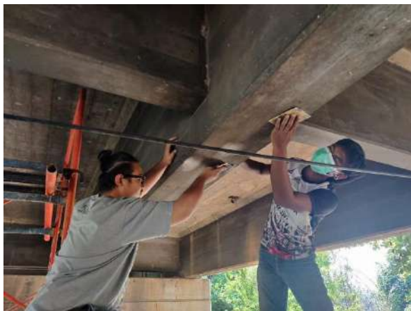
รูปที่ 9-14 ภาพการติดตั้งอุปกรณ์ตรวจวัดสะพาน
