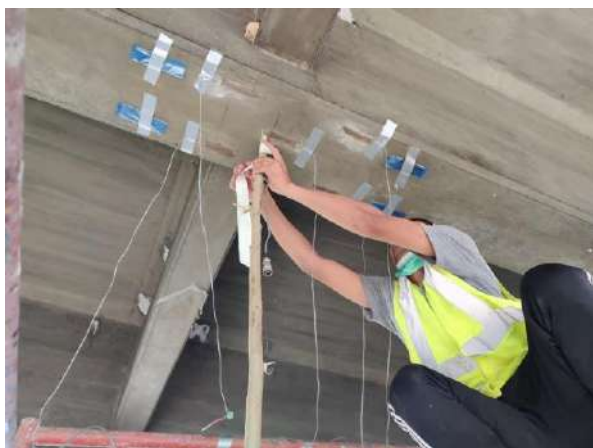
รูปที่ 7-14 ภาพการติดตั้งอุปกรณ์ตรวจวัดสะพาน
