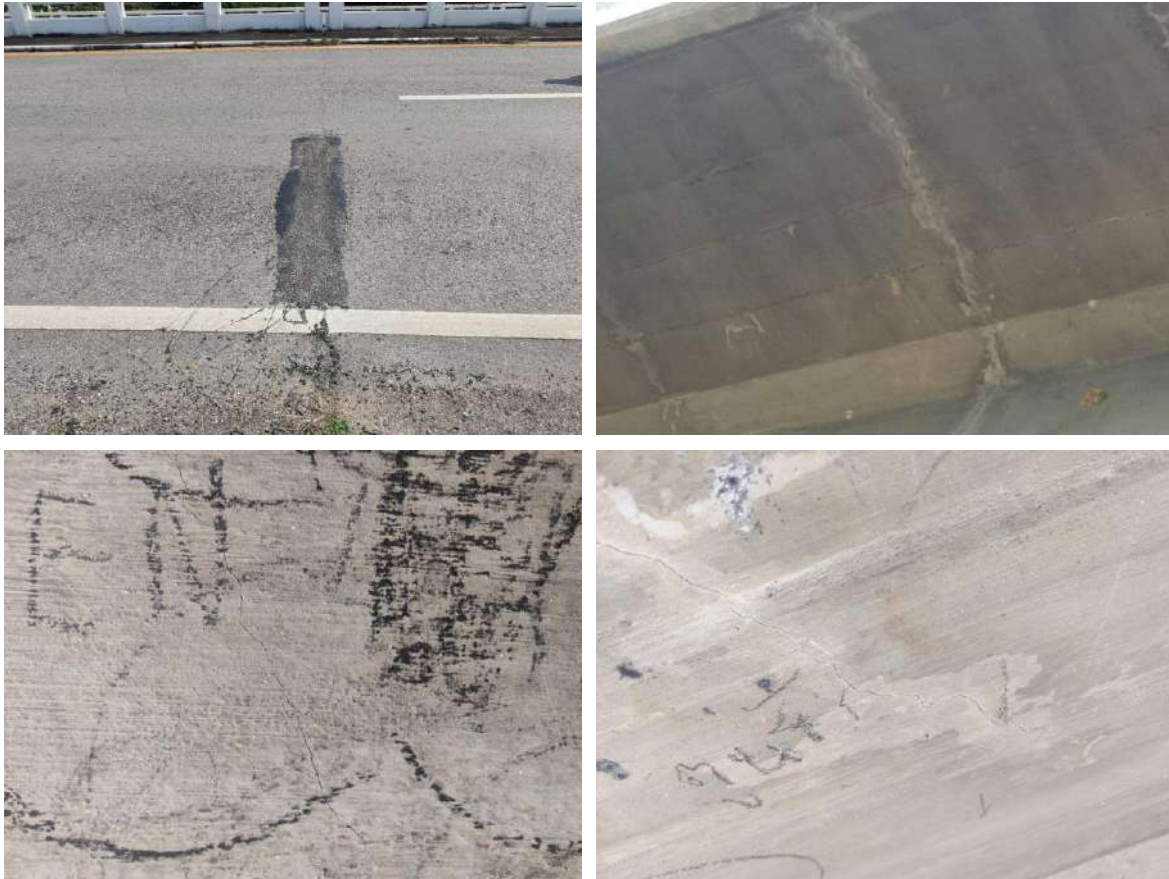
รูปที่ 7-4 ตัวอย่างบางส่วนของภาพความเสียหายของสะพาน
