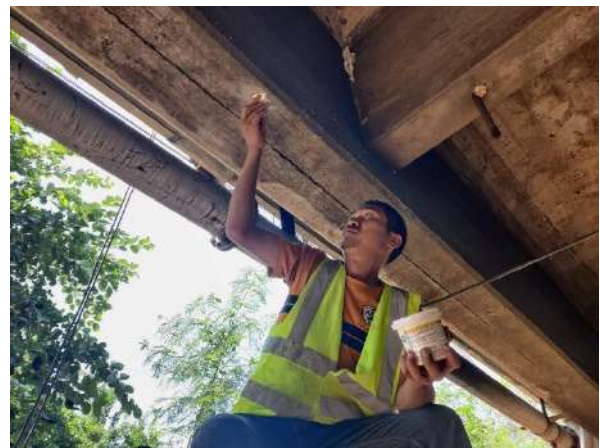
รูปที่ 9-14 ภาพการติดตั้งอุปกรณ์ตรวจวัดสะพาน
