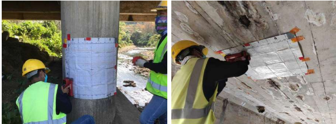
รูปที่ 8-6 รูปการสำรวจรายละเอียดเหล็กเสริมโครงสร้างสะพานด้วยเครื่อง GPR
