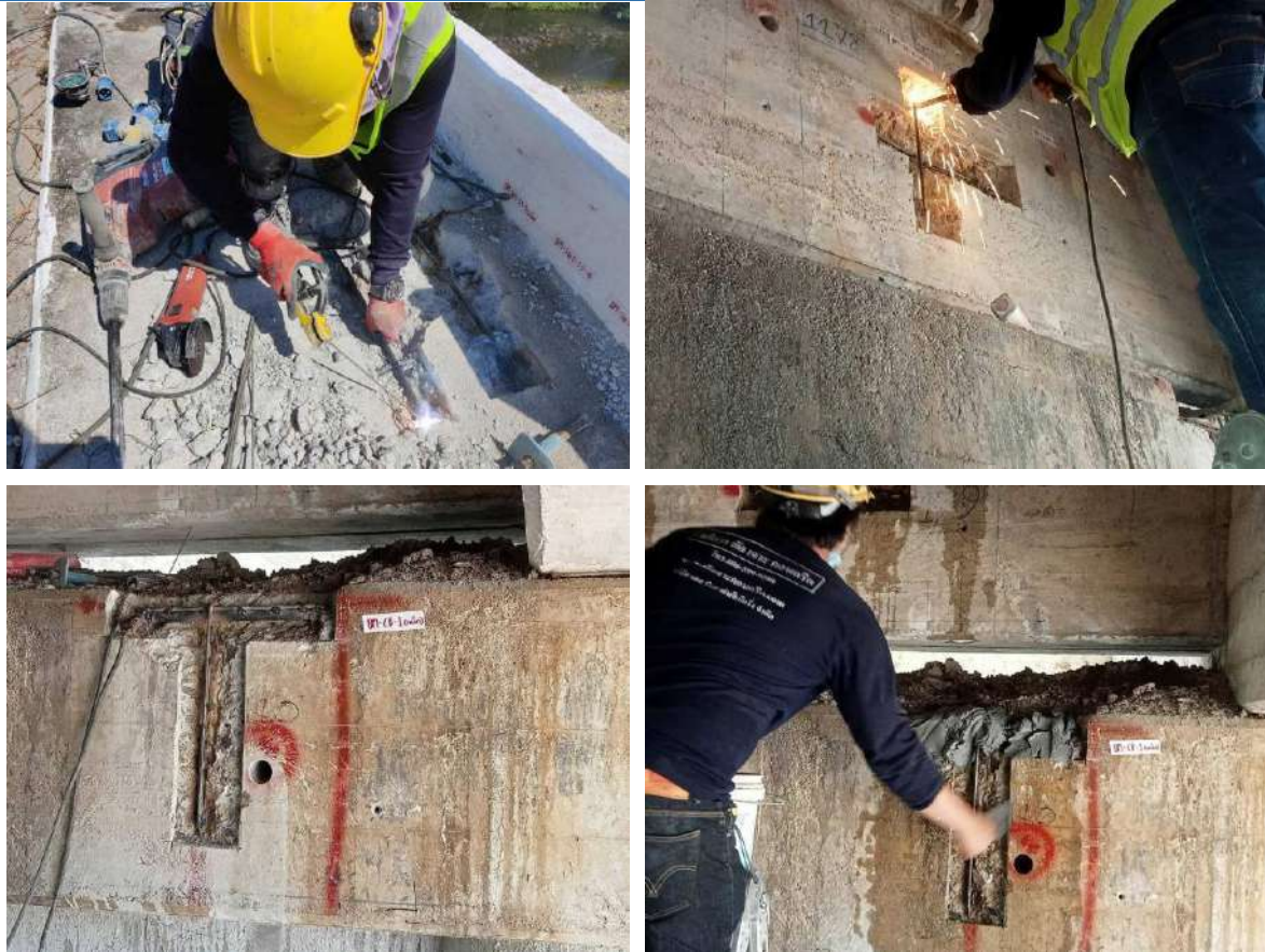
รูปที่ 8-11 รูปการซ่อมคืนสภาพจากการเก็บวัสดุทดสอบกำลังเหล็กเสริม
