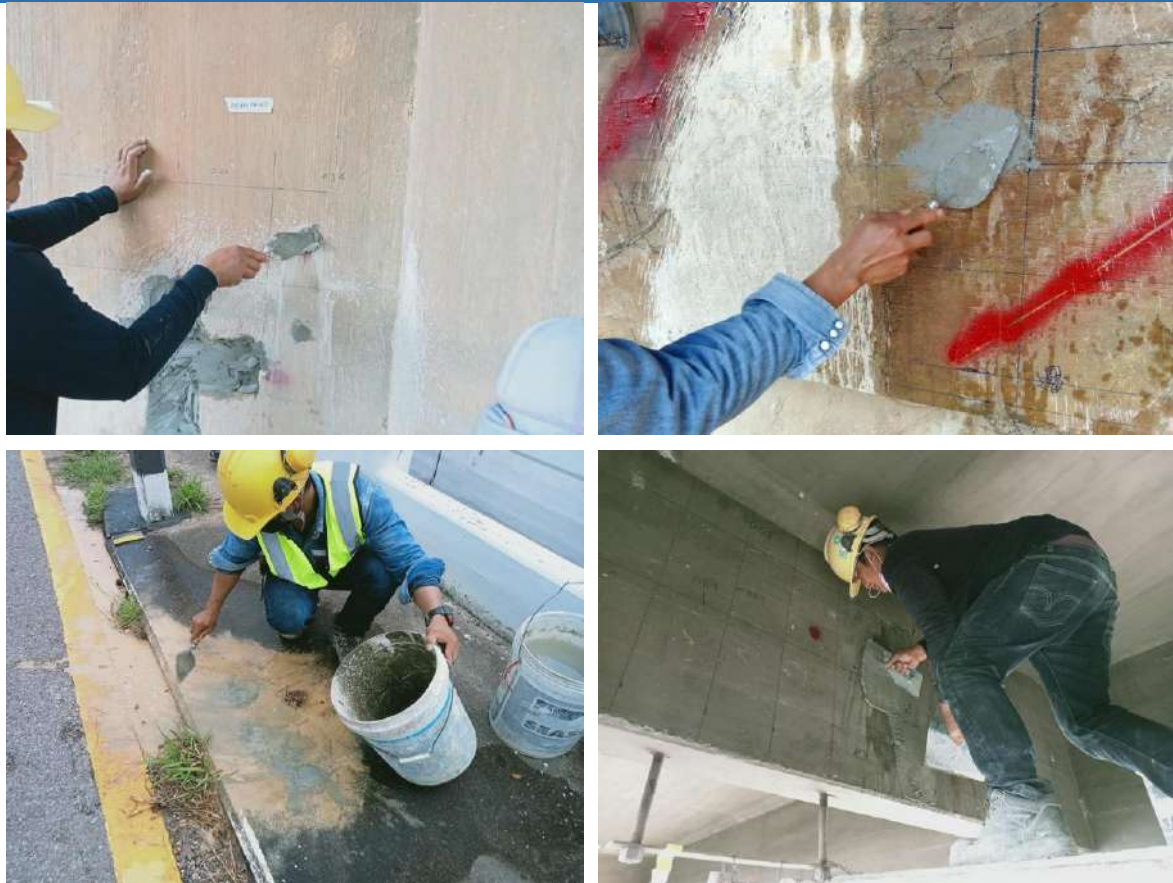
รูปที่ 7-9 รูปการซ่อมคืนสภาพจากการเก็บวัสดุทดสอบกำลังคอนกรีต
