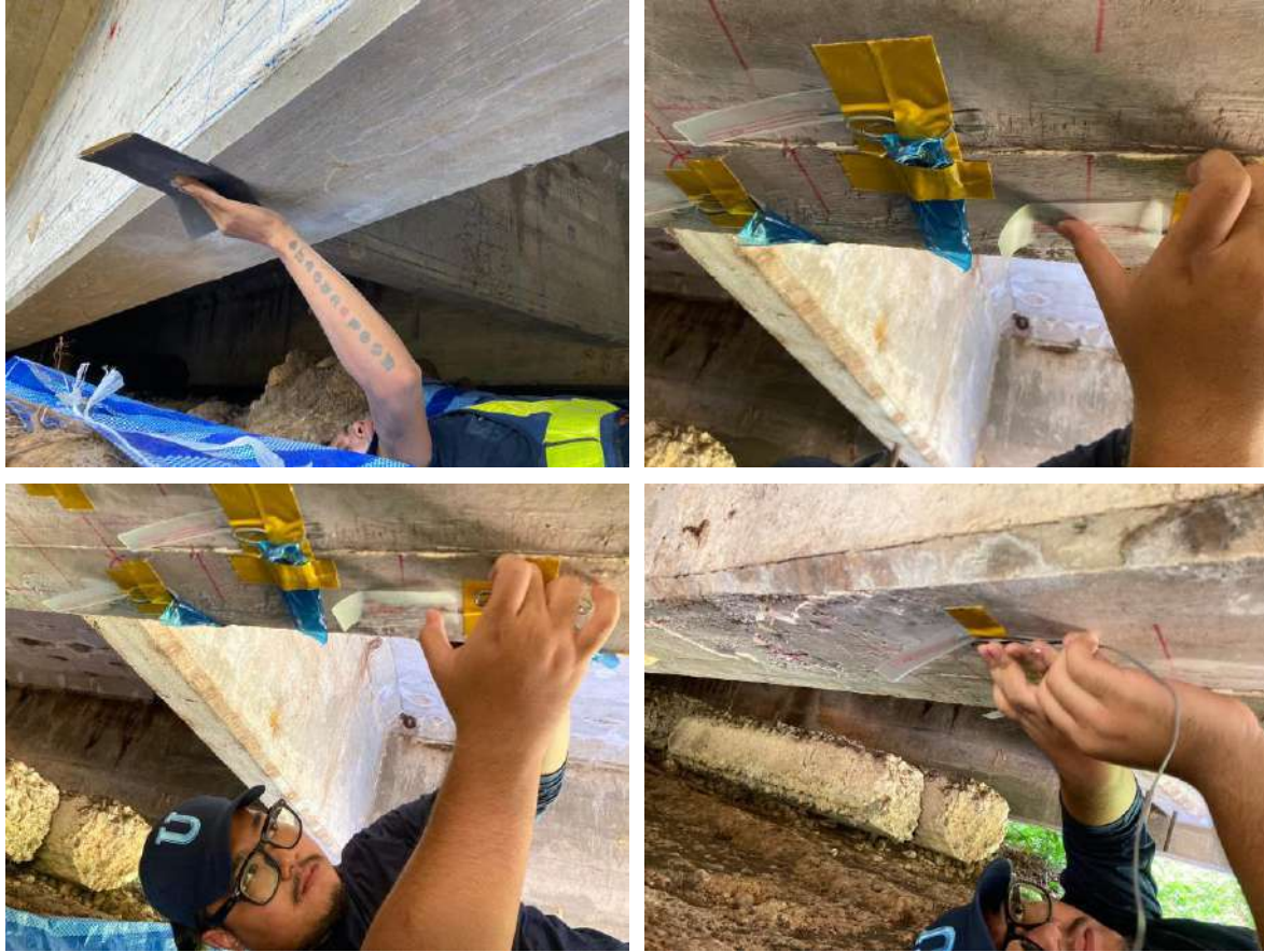
รูปที่ 8-14 ภาพการติดตั้งอุปกรณ์ตรวจวัดสะพาน
