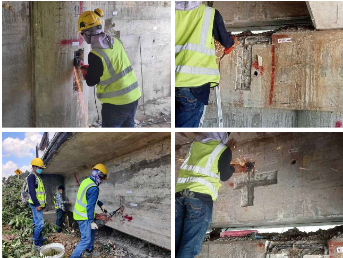
รูปที่ 8-10 รูปการทำงานเก็บวัสดุทดสอบกำลังเหล็กเสริม
