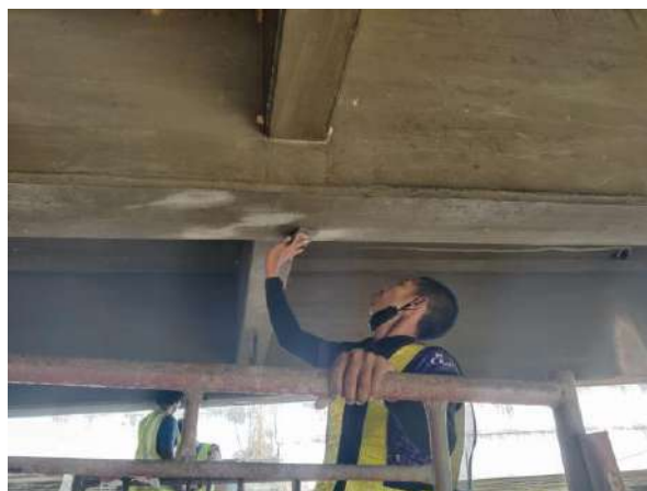
รูปที่ 7-14 ภาพการติดตั้งอุปกรณ์ตรวจวัดสะพาน
